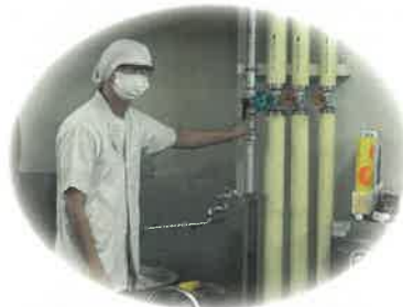
調理員はすぐにガスの元栓を閉める
